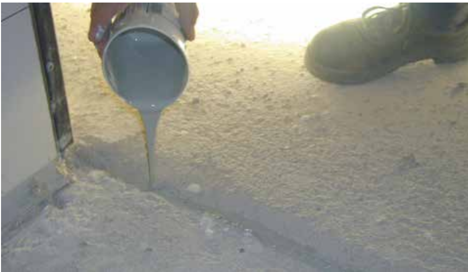
Aljzatrepedések tömítése EPORIP epoxigyantával
