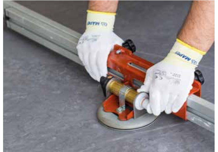
A pumpás tapadókorong elhelyezése
