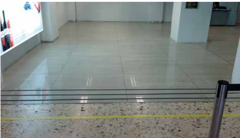
Burkolólap lerakása meglévő padlóra
