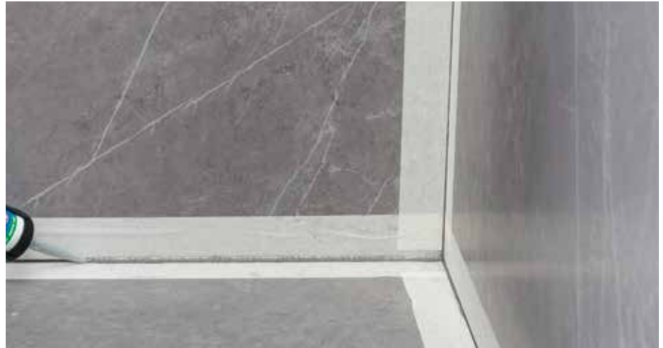
Peremdilataációs hézag kitöltése MAPESIL AC -val
