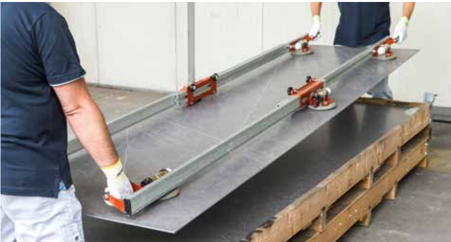
A burkolólap szakszerű mozgatása
