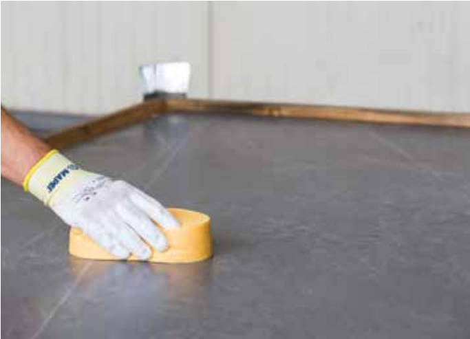
A vákuumos tapadókorongok és a burkolólapok felületének megtisztítása
