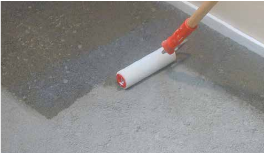
A PRIMER G alapozó felhordása
