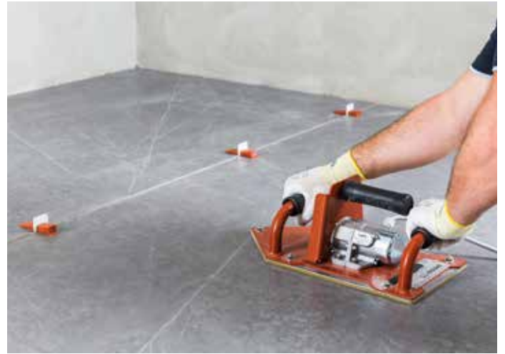
A burkolólapok kézi szerszámmal vagy rázólemezzel történő egyengetése
