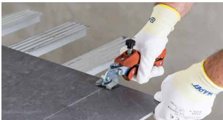
A burkolólap bevágása lapvágó ollóval
