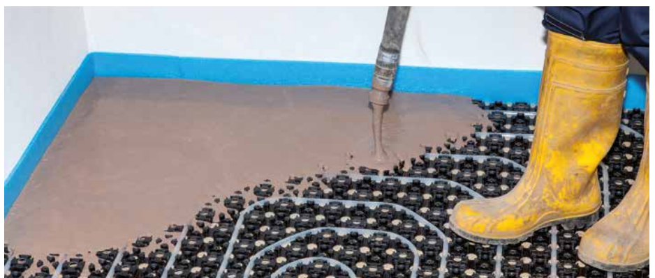
Sugárzó hőhatásnak kitett kompakt esztrich készítése NOVOPLAN MAXI -val
