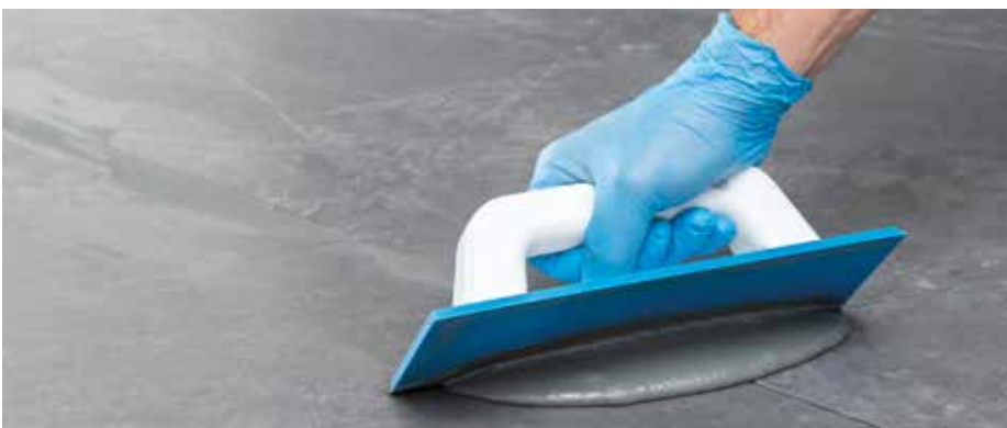
A burkolólapok fugázása
