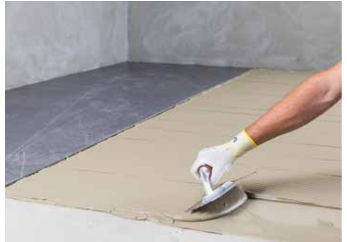
A ragasztóanyagot ugyanabban az irányban kell felhordani a burkolólap hátoldalára és az aljzatra
