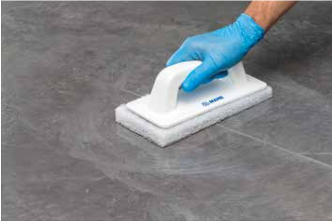
A burkolólapok tisztítása Scotch-Brite tisztítófilccel, majd a végső lemosásuk egy szivaccsal
