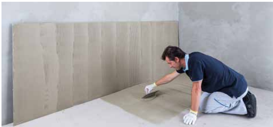
Burkolólap kétoldalú ragasztással történő lefektetése
