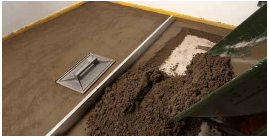
TOPCEM PRONTO felhasználásával készült esztrich készítése
