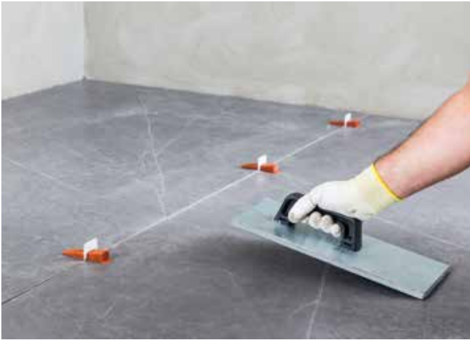
A burkolólapok kézi szerszámmal vagy rázólemezzel történő egyengetése
