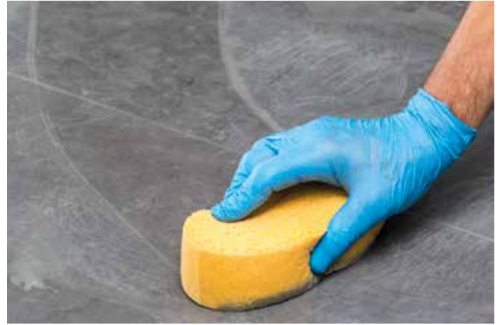
A burkolólapok tisztítása Scotch-Brite tisztítófilccel, majd a végső lemosásuk egy szivaccsal
